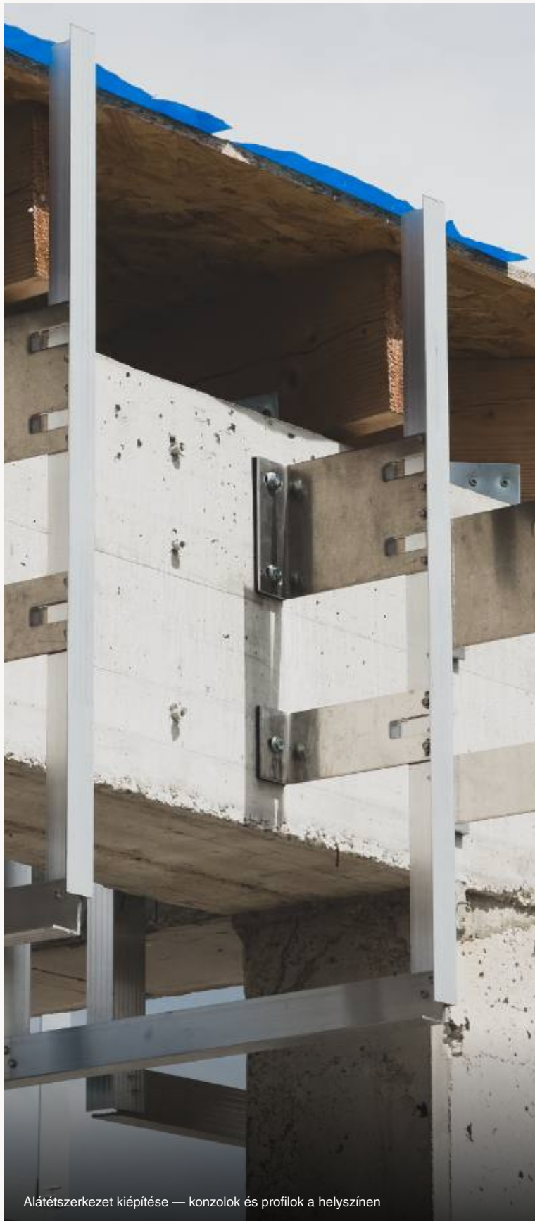
Szellőztetett homlokzat kialakítása, hőszigeteléssel
